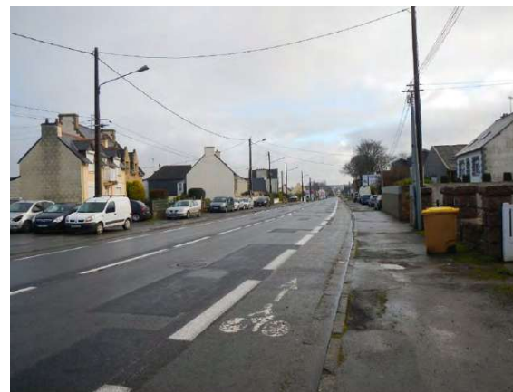
Figure 122 : Le Boulevard de l'Atlantique (Source : EGIS, janvier 2022)
