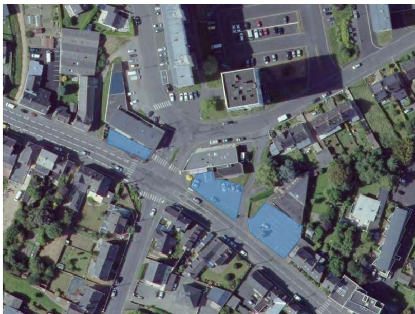
Figure 148 : Photographie aérienne des 3 parkings du carrefour Saint-Jouan – Prise de vue 23/06/2018 (Source : Géoportail)
