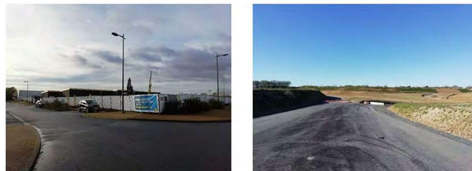
Figure 84 : Zone ne travaux (Source : EGIS, 07/04/2021 et 29/11/2021)
