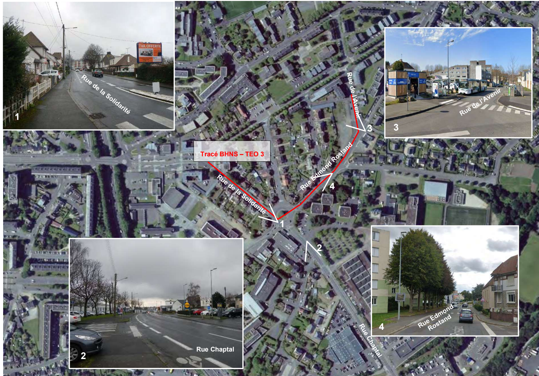
Figure 17 : Localisation des photos et photos – TEO 3C Est (Source : EGIS, janvier 2022)
