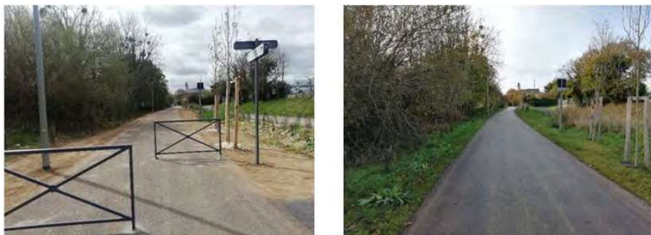
Figure 86 : Piste cyclable et piétonne (Source : EGIS, 07/04/2021 et 29/11/2021)
