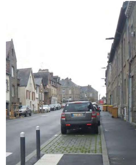
Figure 52 : Stationnement en pavés joints enherbés rue de la Corderie (Source : EGIS, janvier 2022)
