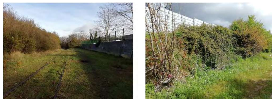
Figure 85 : Voie ferrée désaffectée et fourrés (Source : EGIS, 28/04/2021 et 29/11/2021)
